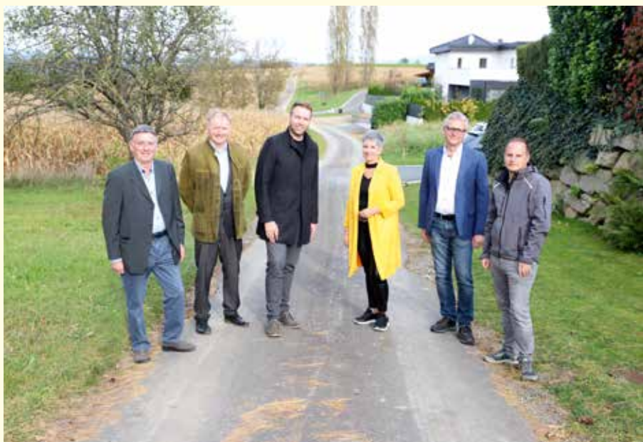
Bgm. Günter Müller mit den Gemeindevertreterinnen und Gemeindevertretern und den am Bau beteiligten Firmen beim Baustart für das Projekt „Forstweg“.
