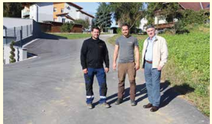
Ein Wegstück in Katzensgreith Richtung Schölböng wurde asphaltiert.
