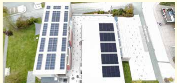
Auf dem Dach der VS ist bereits eine PV-Anlage installiert. Nun wurde eine weitere PV-Anlage auf dem Dach des Turnsaals mit 35 kWp und einem 58 kWh-Speicher errichtet, um das Gemeindehaus mit Strom zu versorgen.
