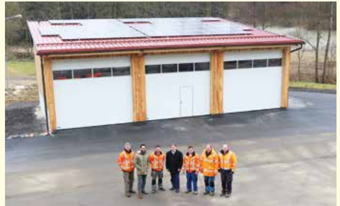
Am Gelände des Bauhofes wurde eine neue Maschinenhalle mit Photovoltaikanlage errichtet.
