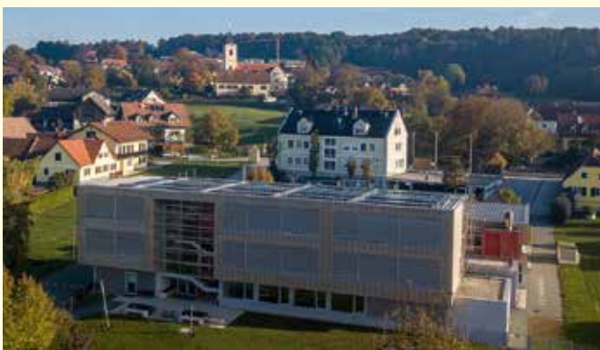
Die Photovoltaikanlage auf dem Dach der Volksschule mit 36 kWp und einem 40 kWh-Speicher wurde in Betrieb genommen.
