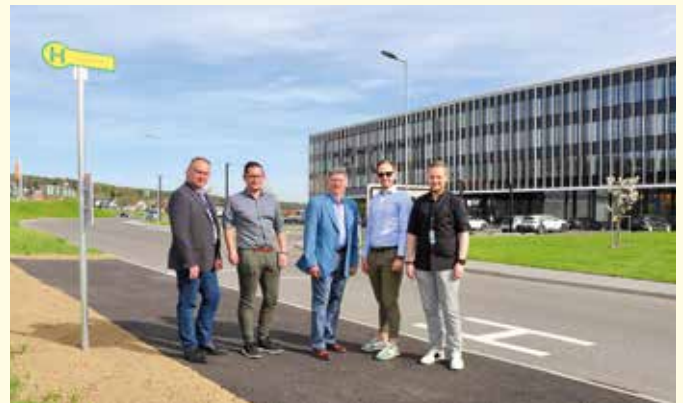
Am RINGANA Campus im Gewerbegebiet in St. Johann wurde eine neue Bushaltestelle errichtet.
