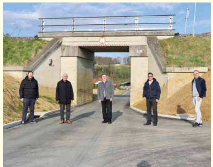
Die Straßendurchfahrt in Unterlungitz im Bereich Stallgebäude Handler Richtung Objekt Romirer („Durchlass“) wurde vertieft.
