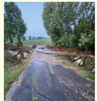
Verklammerung bei einer Brücke in Unterlungitz.
