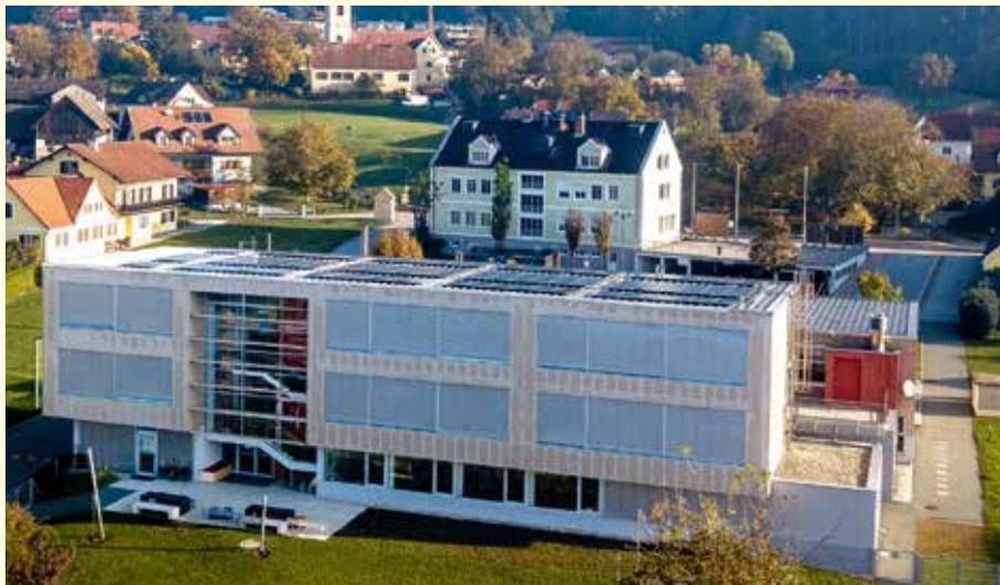
Am Dach unserer Volksschule wurde eine Photovoltaikanlage mit einer Leistung von 36,1 kWp installiert.
