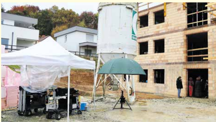
Die Baustelle für die neuen Wohnungen der Firma Krauck-Systems war Drehort für die neueste Folge des Steirerkrimis mit dem Titel „Steirergeld“.
